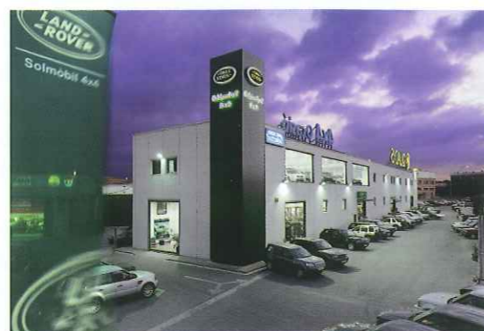
Detalle de las instalaciones de Sant Quirze.
